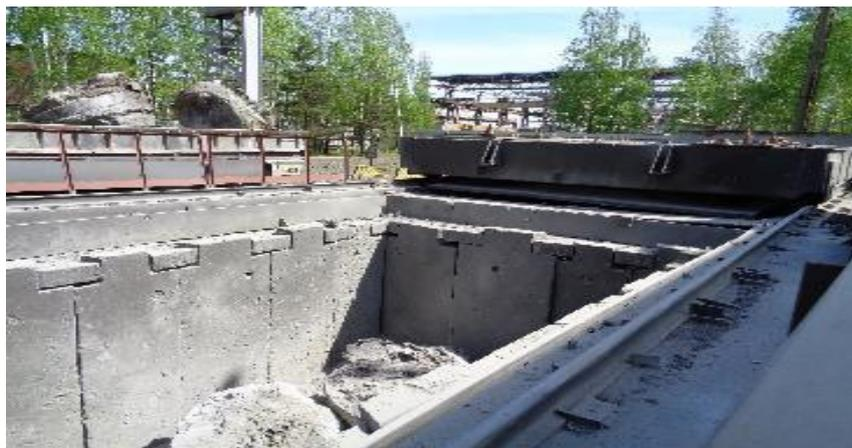
Рис. 6. Броняма копрового цеха после взрывного дробления
