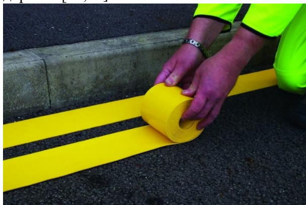
Рис. 4. Устройство временной разметки с помощью полимерных лент
